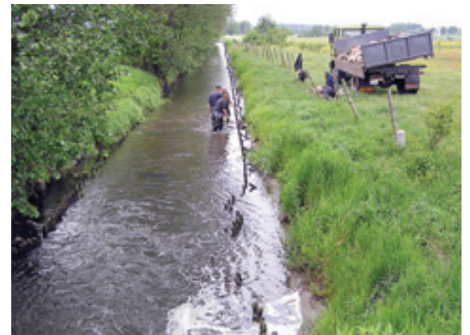
Prace w korycie rzeki nad urozmaiceniem struktury dna
