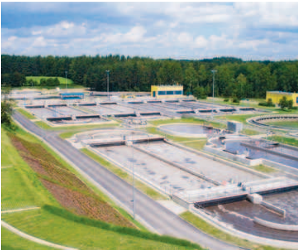
Oczyszczalnia ścieków w Olsztynie
