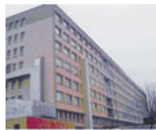
Jedno ze skrzydeł Wojewódzkiego Szpitala Specjalistycznego w Olsztynie, docieplone w ramach inwestycji współfinansowanej przez WFOŚiGW w Olsztynie.
