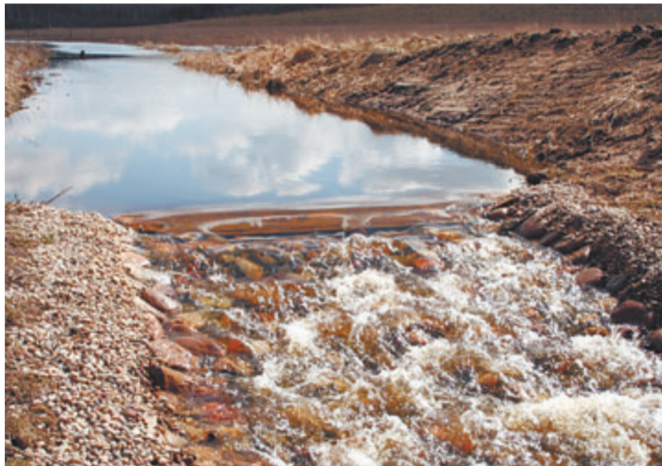
Działania Nadleśnictwa polegały m.in. na budowie progów piętrzących oraz grobli ziemnych i zatrzymaniu wody na bagnach i w zagłębieniach terenu Fot. Nadleśnictwo Wichrowo
