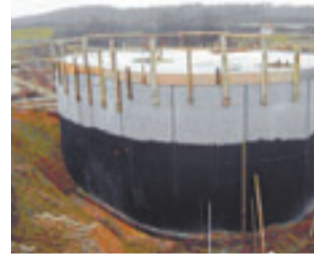
Prace na modernizowanej przez Gminę Dąbrówno oczyszczalni ścieków.
