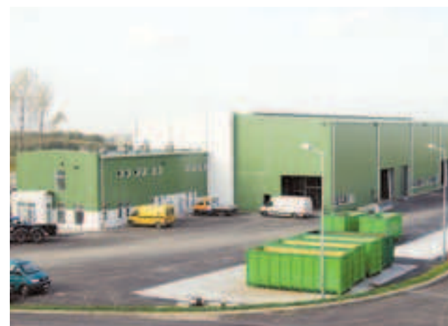
10 grudnia 2008 roku oddano do użytku Zakład Unieszkodliwiania Odpadów Komunalnych w Rudnie koło Ostródy
